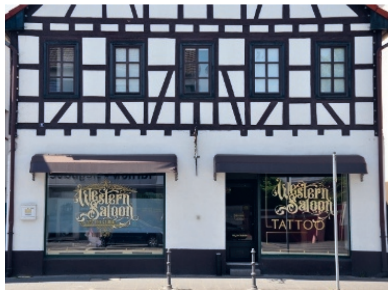
Werbeanlage / Markise Frankfurter Straße
