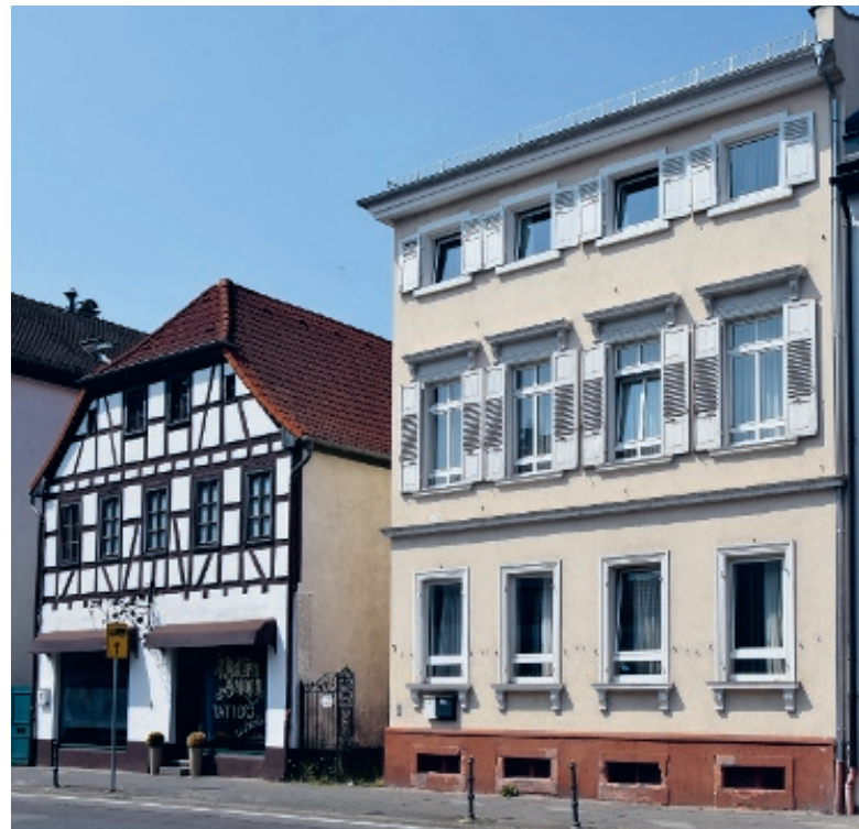
Fachwerkfassade / Putzfassade Frankfurter Straße
