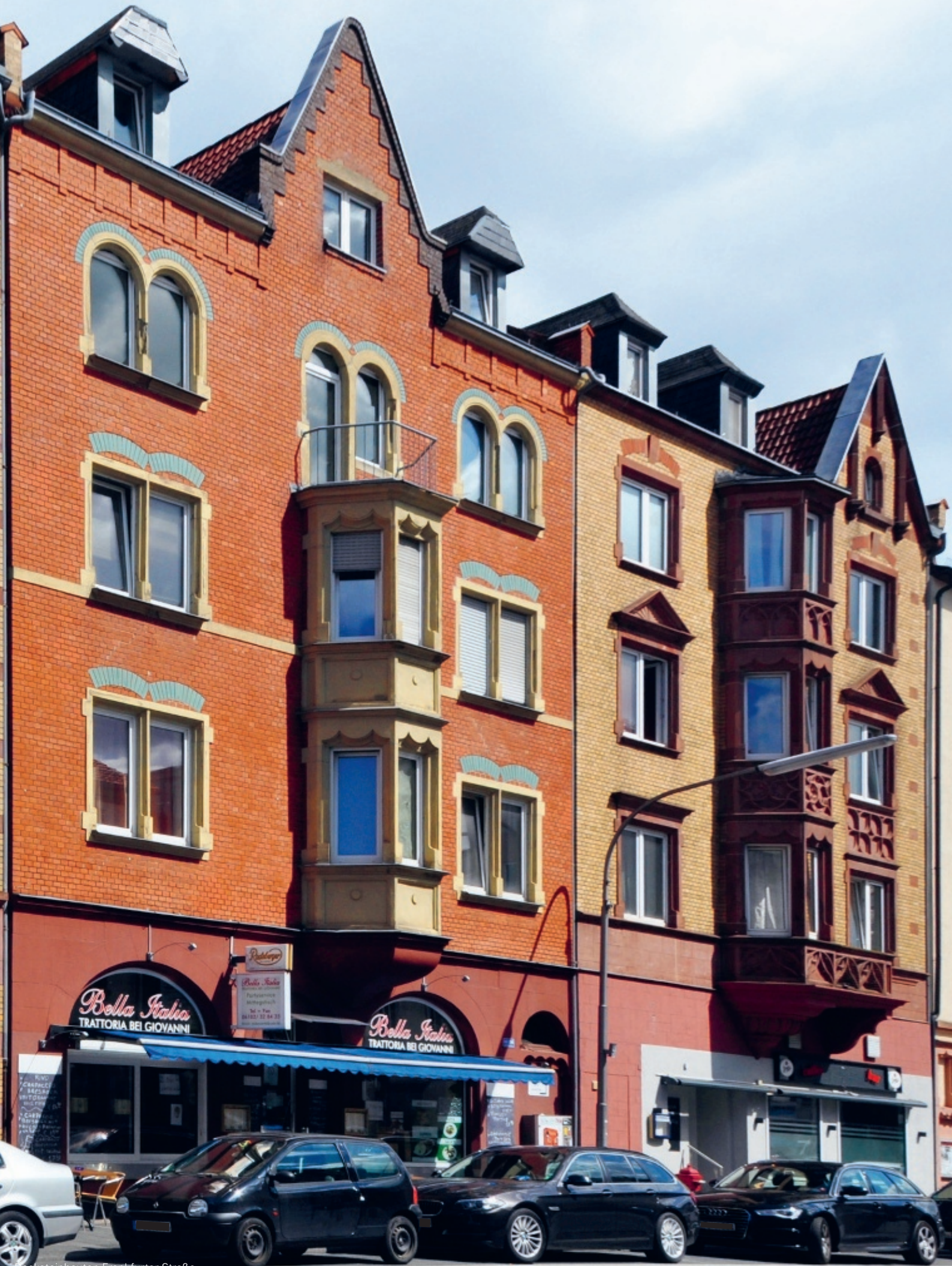
Bäcksteinbauten Frankfurter Straße
