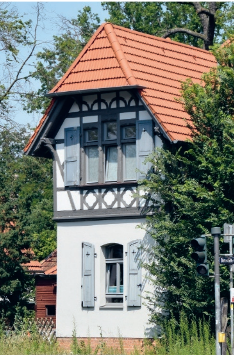
Fachwerkbebauung Frankfurter Straße / Friedensallee
