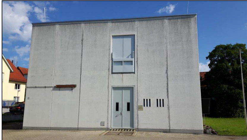
Abb.: Zweigeschossiges Telekom-Gebäude
