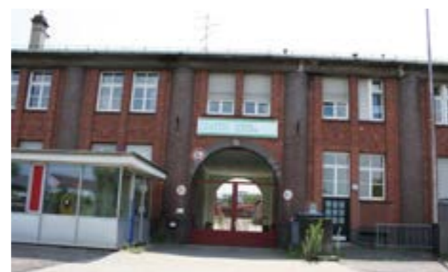
Abb. 29: Außenansicht Bundesbranntweinmonopolverwaltung, Quelle: ProjektStadt 2018
