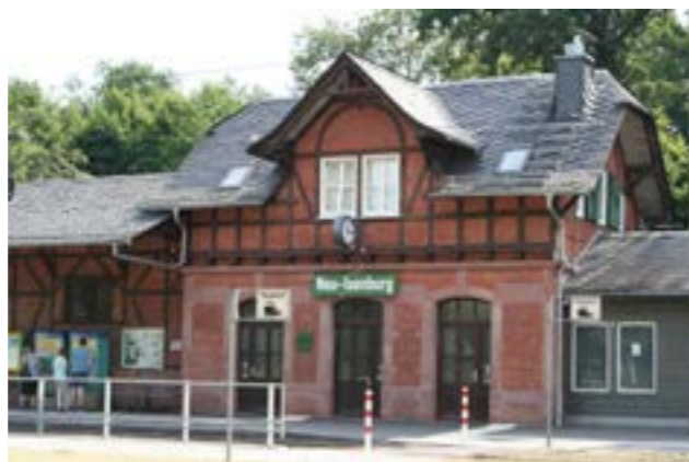
Abb. 49: Straßenbahnhaltestelle Neu-Isenburg Stadtgrenze, Quelle: ProjektStadt 2018
