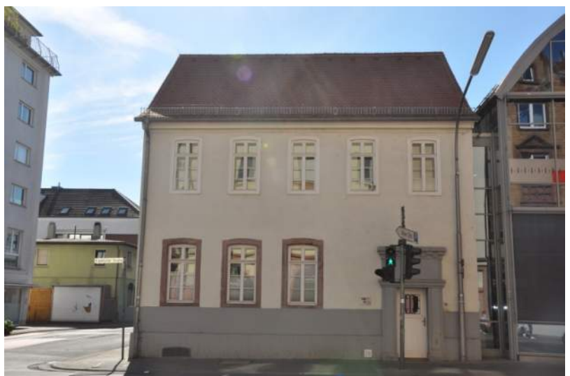
Abbildung 11: Denkmalgeschütztes ehem. deutsch- lutherisches Schul- haus Frankfurter Straße 55 erbaut 1781 heute Bürgeramt
