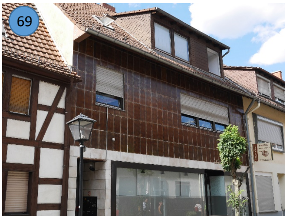
Foto 17: Fassadengestaltung entspricht nicht der Gestaltungssatzung
