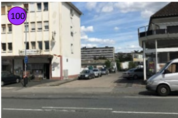
Foto 48: Kalbskopf (Blick von der Frankfurter Straße)
